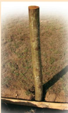
Un Cercado con CABLE crea fuertes tensiones mecánicas en todos los postes ( más los galvanizados que los de aluminio ). Por tanto es necesario realizar un plano de instalación para evitar, en la medida de lo posible, cambios de dirección y esquinas.
